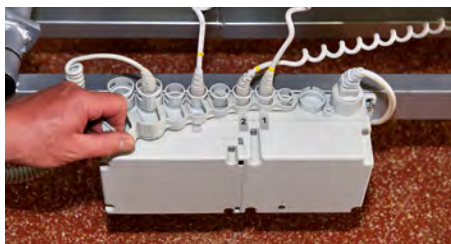
Abb. 02a Kabelsicherung abziehen
